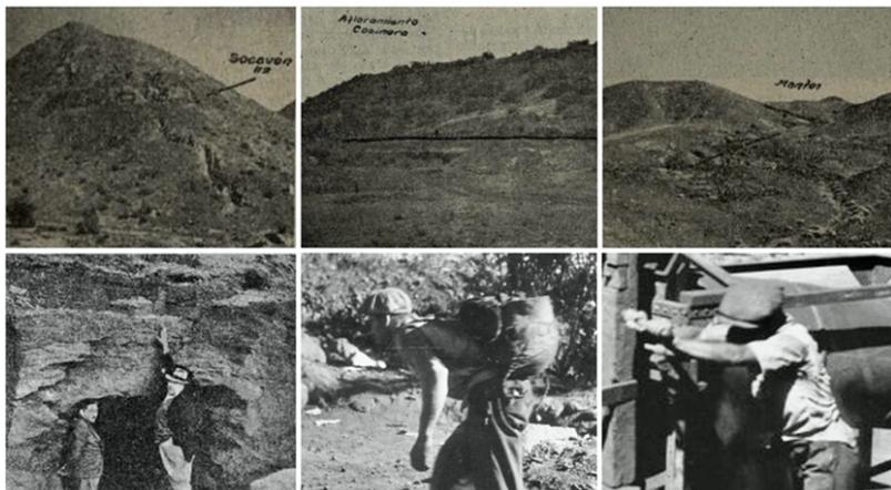
**Figura 1:** En las fotografías superiores, se aprecian los lugares de extracción del manganeso a través de socavones y mantos. Abajo, se aprecian los modos artesanales de traslado y procesamiento rudimentario del mineral en la década de 1940. Archivo del autor.
