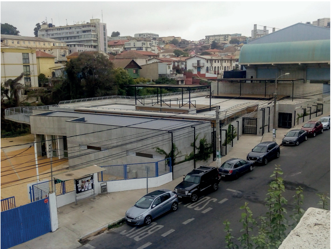
Imagen 23. Vista general desde la Facultad de Arquitectura. Acceso principal y patio con las pérgolas.
