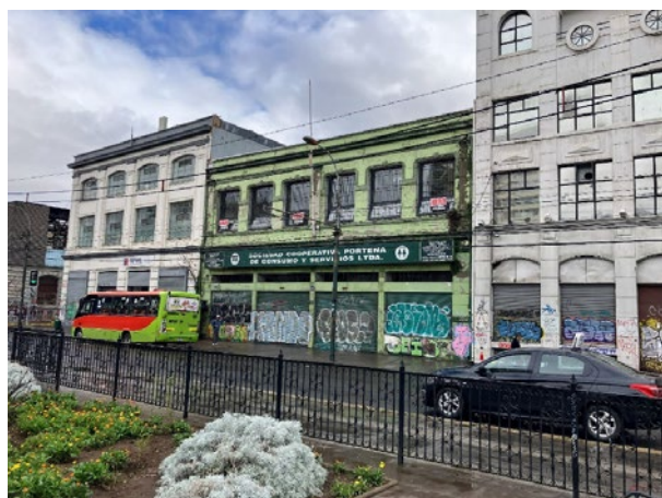
>> Figura 31. Fotografía fachada original Av. Brasil. Fuente: fotografía cortesía de Joaquín Velasco e Ignacio Pérez.
