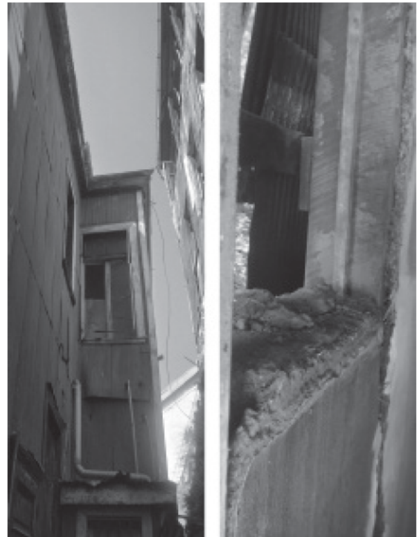
>> Figura 9. Revestimiento de zinc y estructura de adobillo a la vista en Casa Frugone, Cerro Concepción. Fuente: elaboración propia. 2025.
