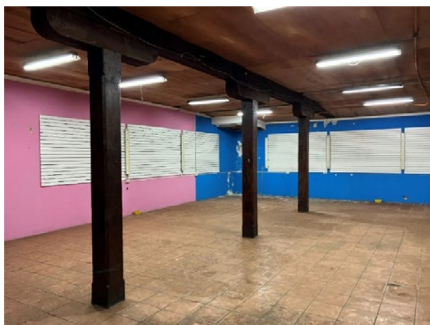
>> Figura 28. Fotografías estado original Nv -1. Fuente: fotografía cortesía de Joaquín Velasco e Ignacio Pérez.
