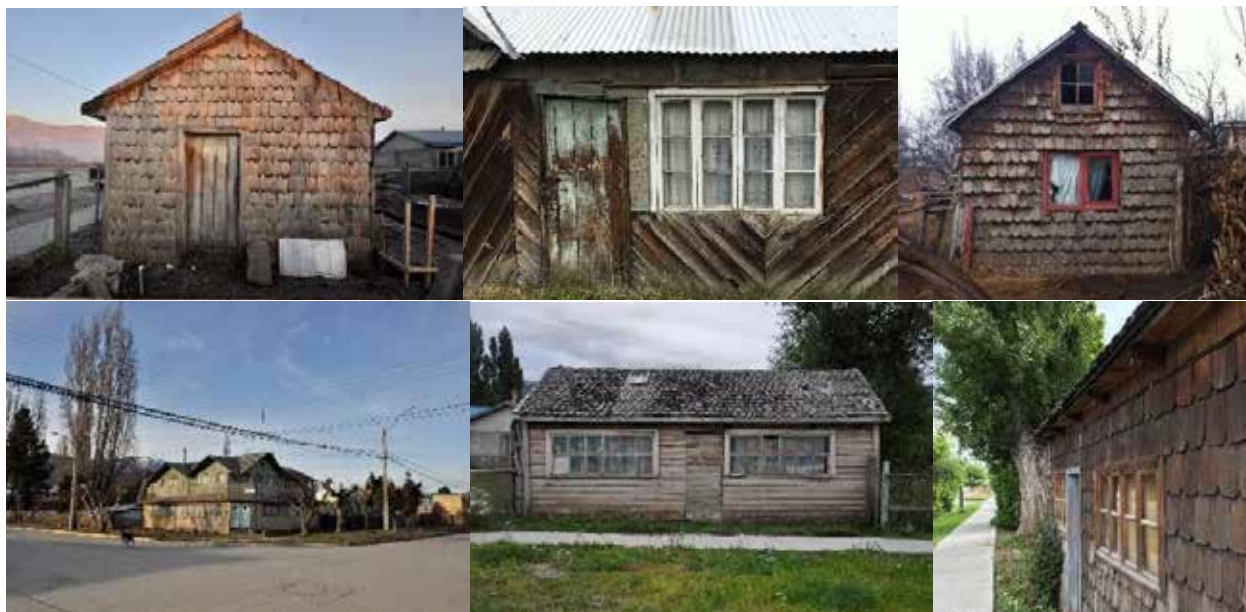
> Figura 18: Fachada casas de Cochrane. Fuente: elaboración propia
