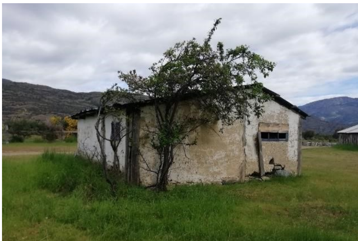
> Fig. 4: Galpón para alimento y maquinaria ganadera. Lago Cochrane, 2021. Fuente: elaboración propia.
