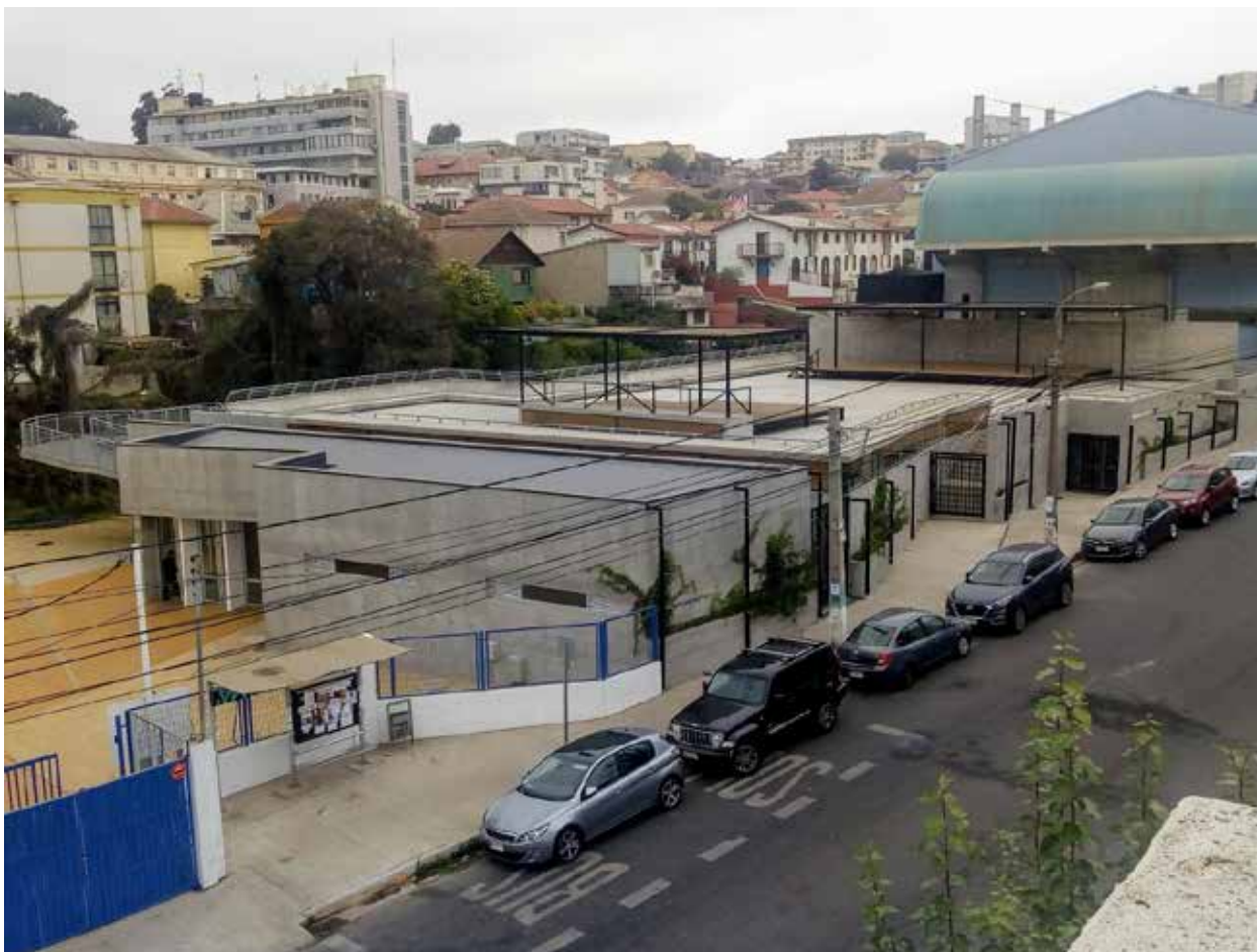
Imagen 23. Vista general desde la Facultad de Arquitectura. Acceso principal y patio con las pérgolas. Fuente: Elaboración propia
