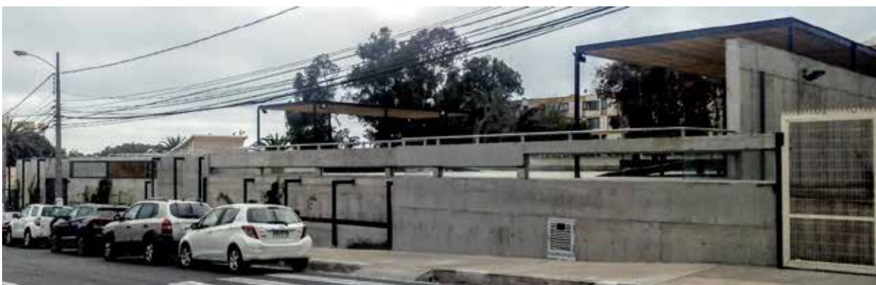
> Imagen 14. Fotografía desde la calle hacia el norte, se aprecian las pérgolas. Fuente: Elaboración propia
