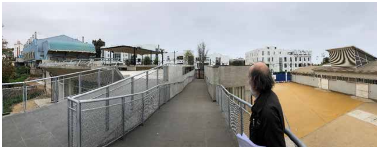
> Imagen 17. Fotografía de rampa superior del proyecto. Fuente: Elaboración propia
