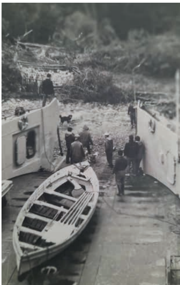
>> Figura 3: Cubierta Central que une las bandas de la barcaza con rampa abatible y huellas de orugas para la carga.
