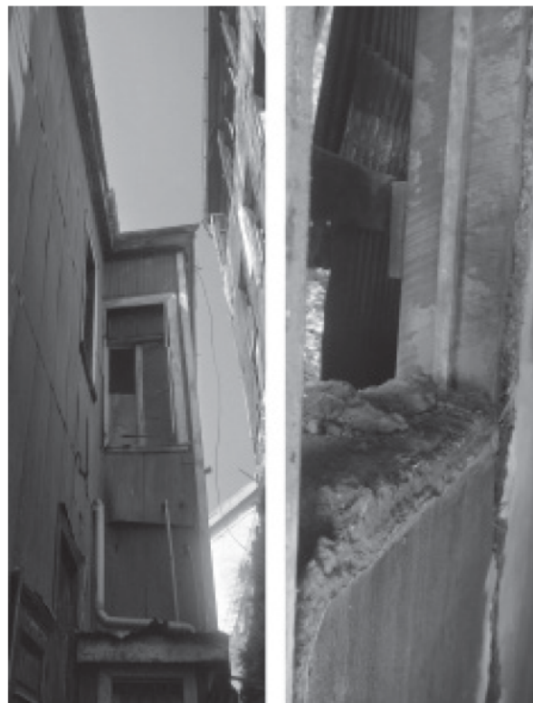
>> Figura 9. Revestimiento de zinc y estructura de adobillo a la vista en Casa Frugone, Cerro Concepción. Fuente: elaboración propia. 2025.
