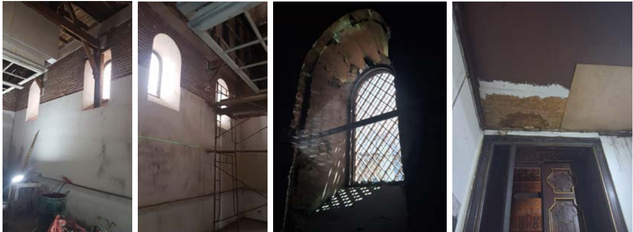
>> Figura 35-38: Apertura de ventanas hacia fachada este, sala de conferencias. Fuente: Elaboración propia.
