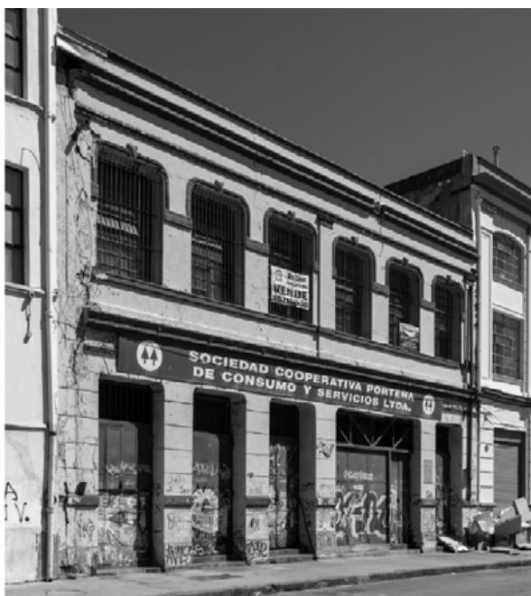
>> Figura 13. Edificio de la Sociedad Cooperativa Porteña, Valparaíso, Chile. Fuente: SoyChile.
