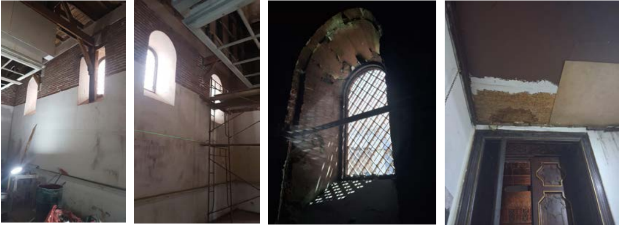
>> Figura 27-30: Apertura de ventanas hacia fachada este, sala de conferencias. Fuente: Elaboración propia.
