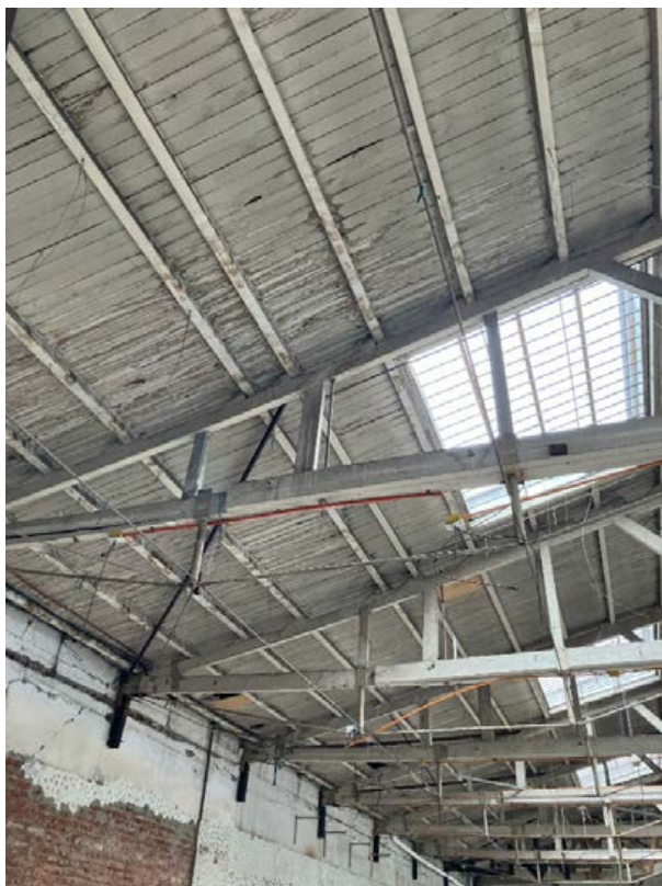
>> Figura 26. Fotografías estado original cerchas y muros Nv 2. Fuente: fotografía cortesía de Joaquín Velasco e Ignacio Pérez.
