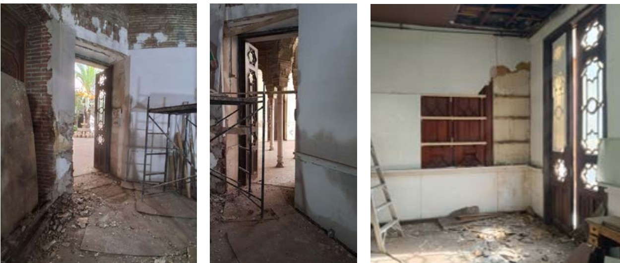
>> Figura 31-32: Proceso decapado de muros y apertura de vanos. Fuente: elaboración propia.
