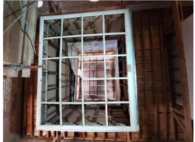
>> Figura 18-19: Imagen situación actual de entablillado de cielo con envigado 3"x6" y lucarna con enrejado metálico. Fuente: Elaboración propia.
