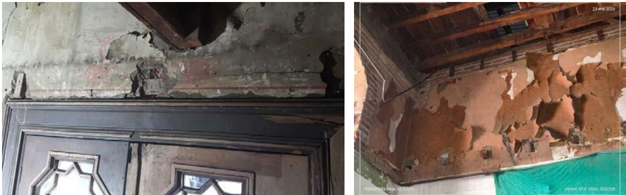
>> Figura 20-21: Restos de papel mural histórico descubiertos bajo capas de pintura durante el retiro de revestimientos. Fuente: Elaboración propia.
